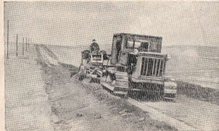
Устройство земляного полотна грейдером
