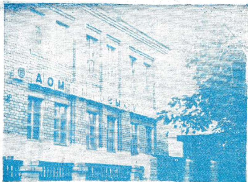
Дом быта в районном центре
